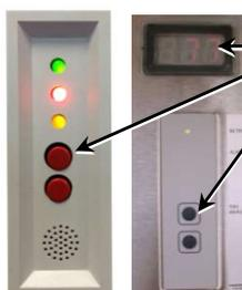
Pulsar el botón "Alarma acústica" y mantenerlo pulsado hasta que el avisador luminoso parpadee rápidamente, después soltar. Se muestra un valor para estanqueidad en el display (103 en la ejecución de la caja VA). Se emite el mismo valor por el número de parpadeos del avisador luminoso "Alarma".
