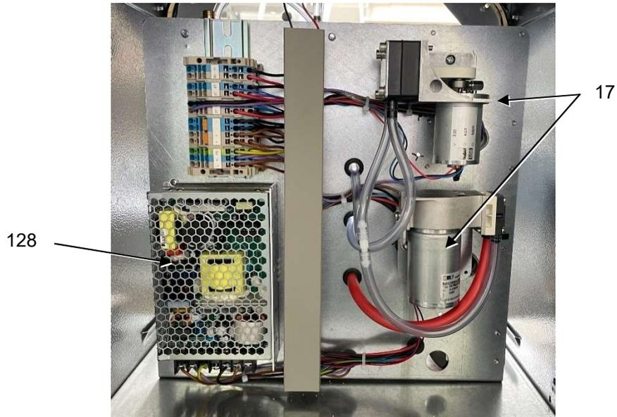
17 Überdruckpumpe, Behälter oben und Rohrleitung unten
