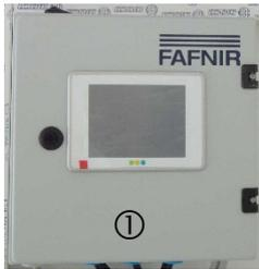
I sensori che sono montati nelle diverse botole di ispezione sono collegati sul dispositivo segnalatore di perdite<sup>①</sup>. Contemporaneamente a questa unità sono collegati anche sensori per il livello nel serbatoio. Il dispositivo segnalatore di perdite è dotato di un'interfaccia utente grafica sulla quale, oltre al livello, sono visualizzati gli allarmi dei sensori.
