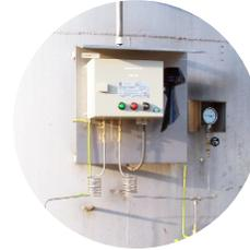
Erster explosionsgeschützter Vakuum-Leckanzeiger: VL-H9
